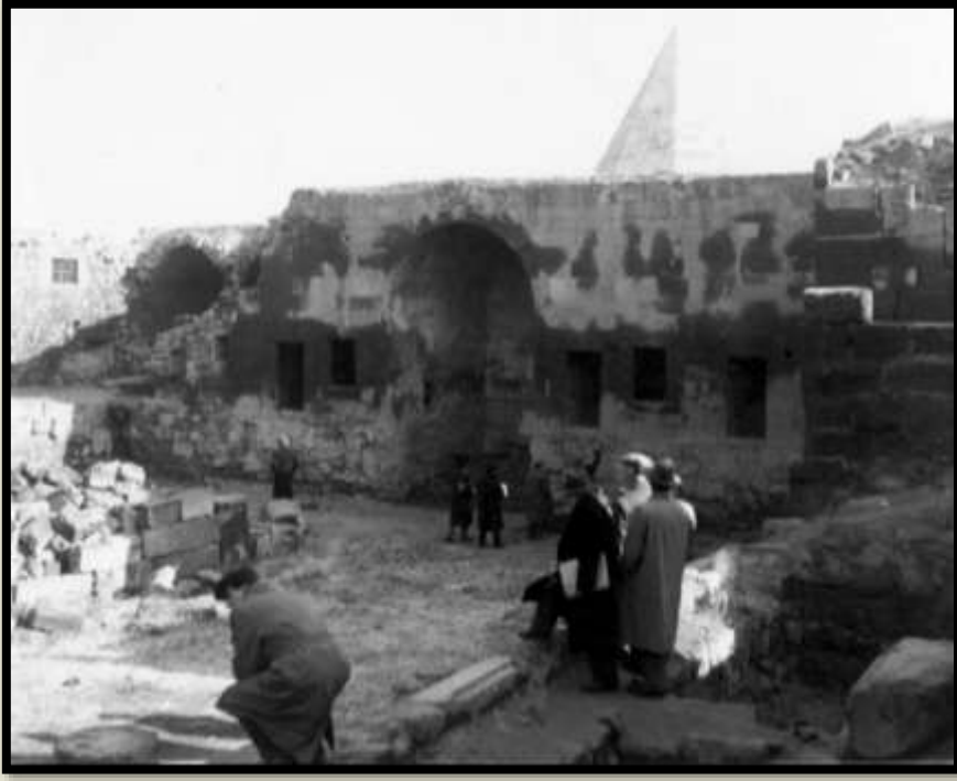
Yapının onarım öncesinde çekilmiş bir fotoğrafı (1955) (N. Karakaya Arşivi)
